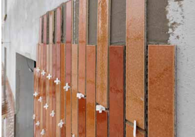
Aussenecke während der Verlegung der Klinkerriemchen
