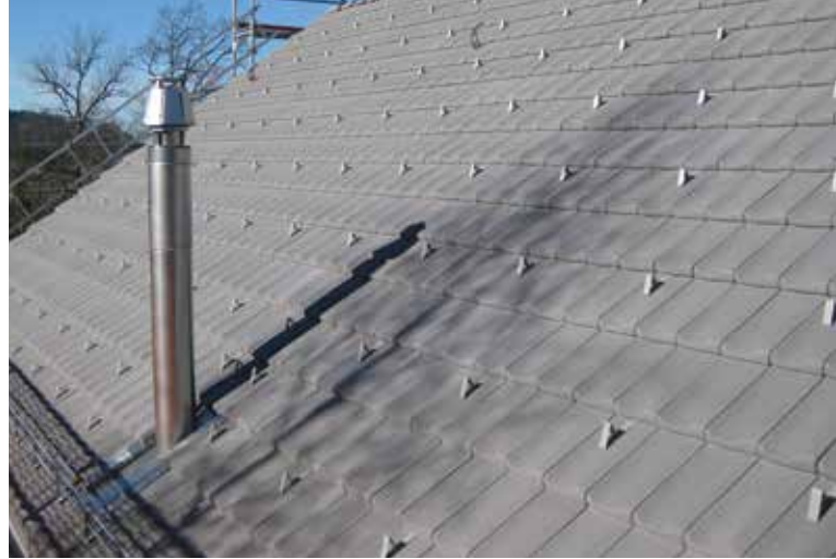
Steildach fertig eingedeckt
