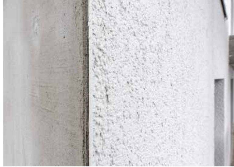
Aussenecke mit aufgetragenem Deckputz
