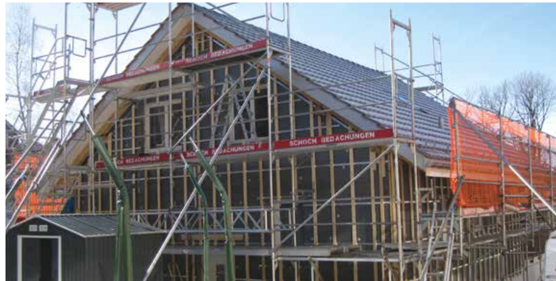
Fertig montierte Traglattung
