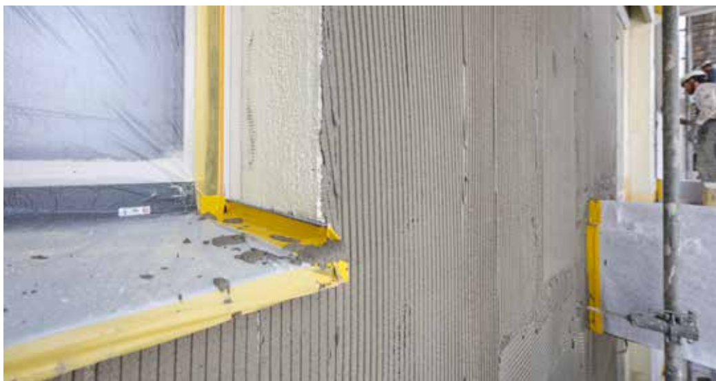
Aufgetragener Grundputz auf swissporPIR-Top023-Dämmplatten
