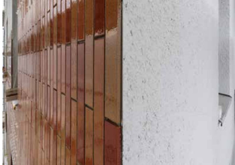
Aussenecke mit fertig verlegten Klinkerriemchen
