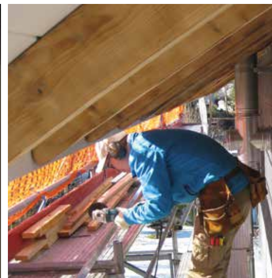
Fertig verlegte Dämmung swissporLAMBDA Vento sowie Vorbereitung der Montage der Traglattung.
