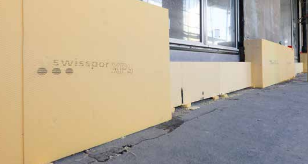
Verarbeitete swissporXPS 300 GE Dämmplatten im Sockelbereich
