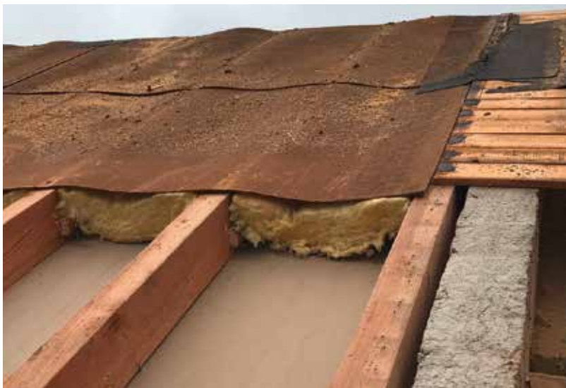
Bestehende Wärmedämmung mit geschupptem Unterdach aus Holzfaserplatten
