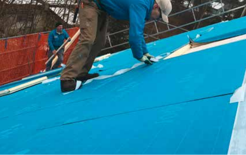
Verkleben der Unterdachüberlappungen durch Abziehen und Andrücken der werkseitig aufgebrauchten Liner
