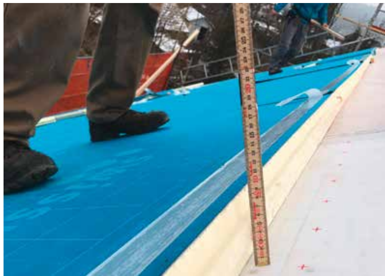
swissporTETTO Alu Difuplan d mm 80 verlegt auf trittfeste Unterlage aus OSB-Platten d mm 15, inkl. Dampfbremse
