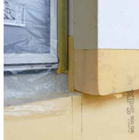
Übergang von swissporXPS 300 GE zu swissporPIR Top023
