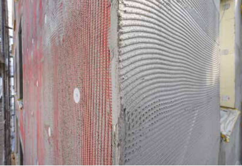
Aussenecke bereit zur Aufnahme der glasierten Klinkerriemchen zum einen (links) sowie dem Deckputz zum anderen (rechts).
