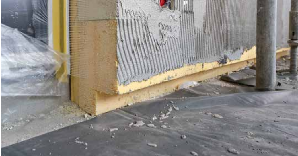
Aufgetragener Grundputz im Sockelbereich
